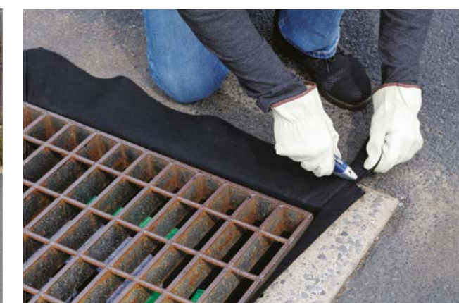
Il tessuto in eccesso attorno alla griglia può essere rifinito per motivi estetici o lasciato in posizione per garantire maggiore aderenza durante la sostituzione.
